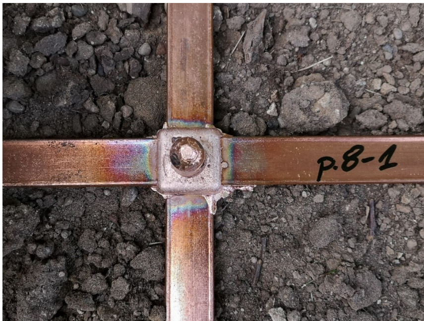
Rys. 12. Dokumentacja fotograficzna prawidłowo wykonanego połączenia egzotermicznego
