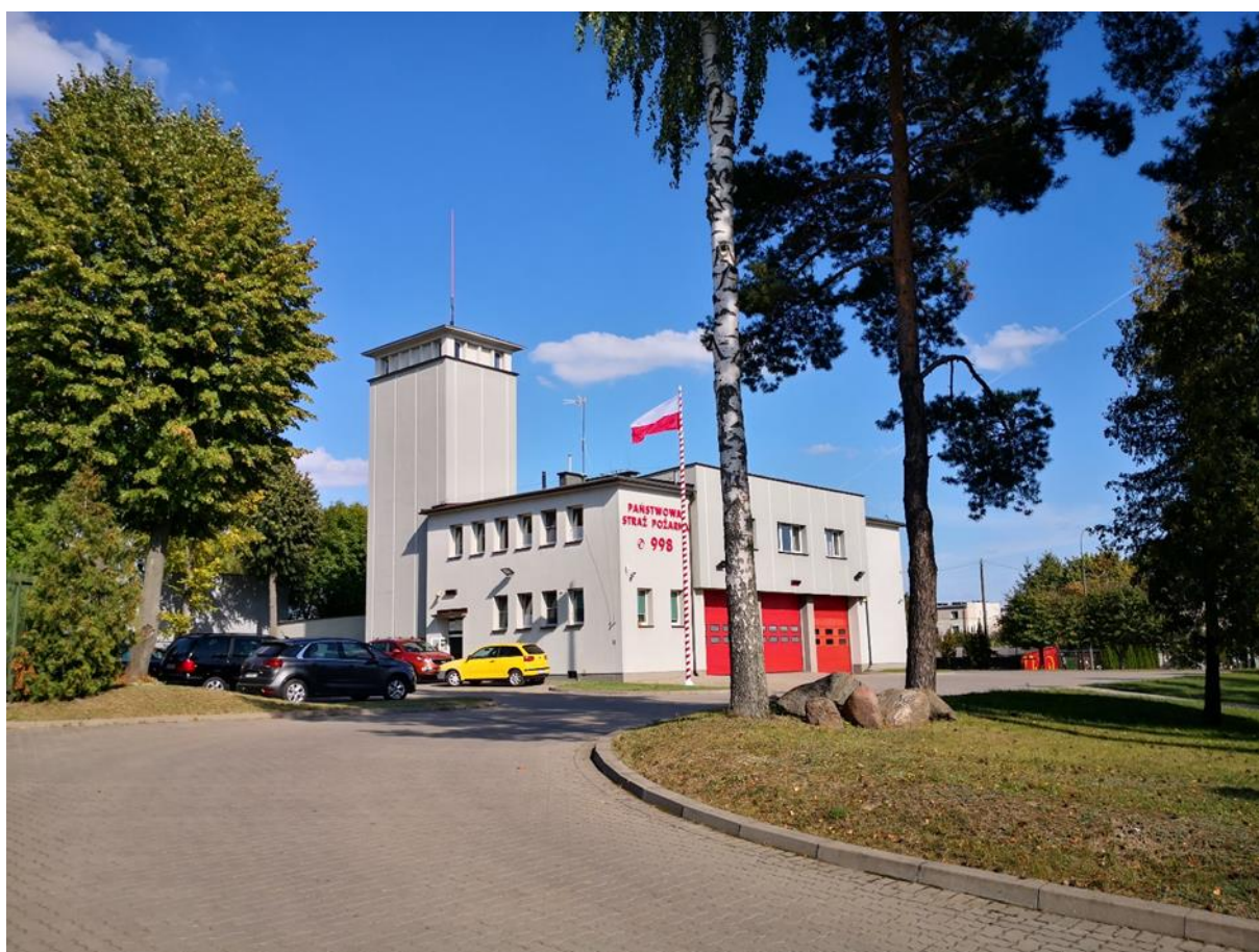
Fot. 2. Budynek Jednostki Ratowniczo-Gaśniczej nr 3 w Białymstoku we wrześniu 2019 r. Zdjęcie: Mirosław Zielenkiewicz
