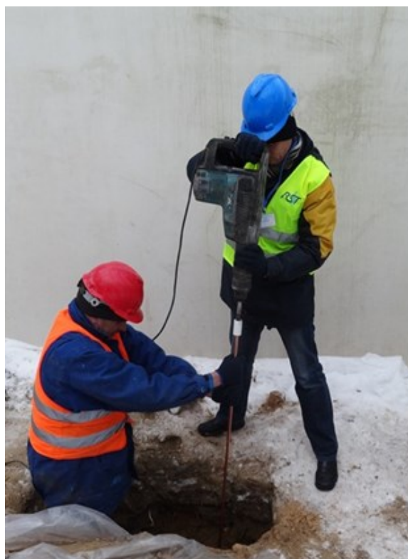
Rys. 3. Pogrążanie uziomu pionowego w ziemi za pomocą wibromłotu
