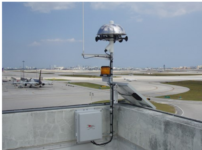
Rys. 3. Przykład stacji sygnalizacji alarmowej systemu TWS z syrenami dźwiękowymi i lampą stroboskopową
