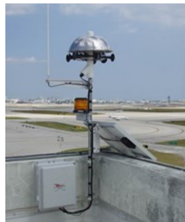
Rys. 4. Zdalna stacja syren
