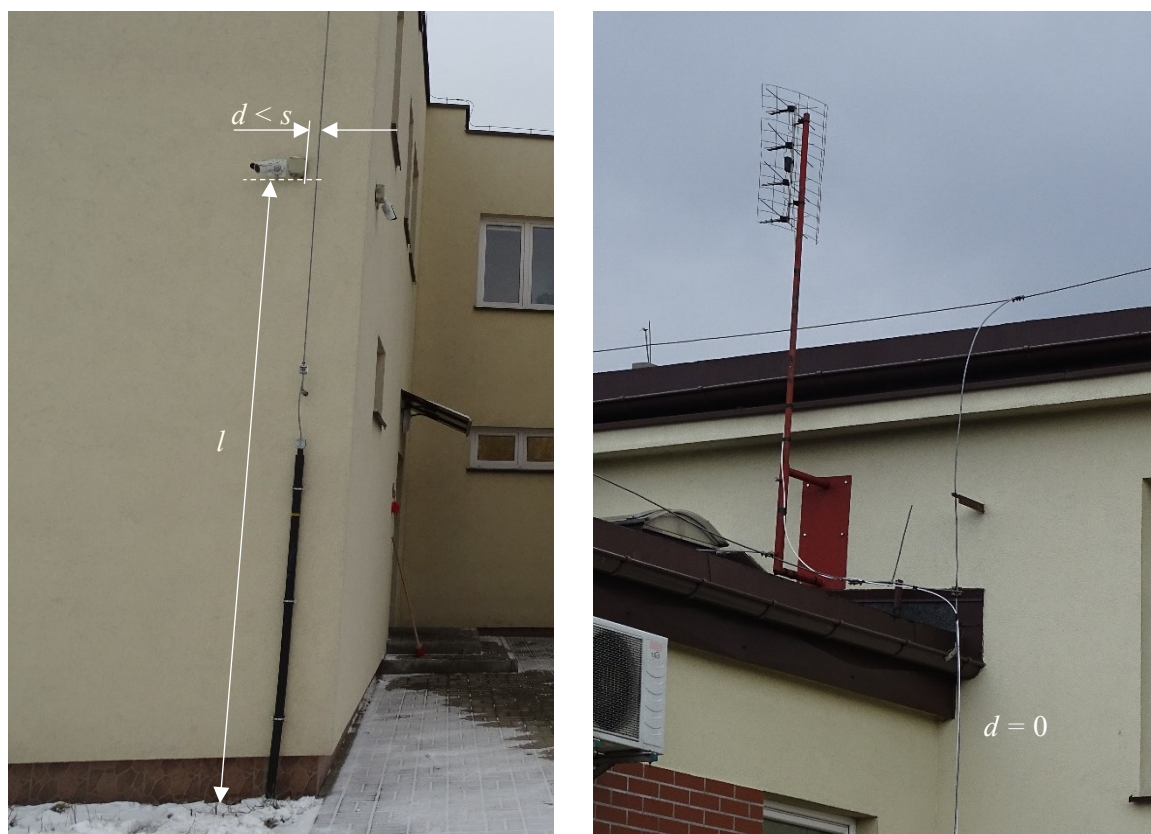
Rys. 1. Przykłady typowych błędów związanych z brakiem zachowania odstępów separujących
