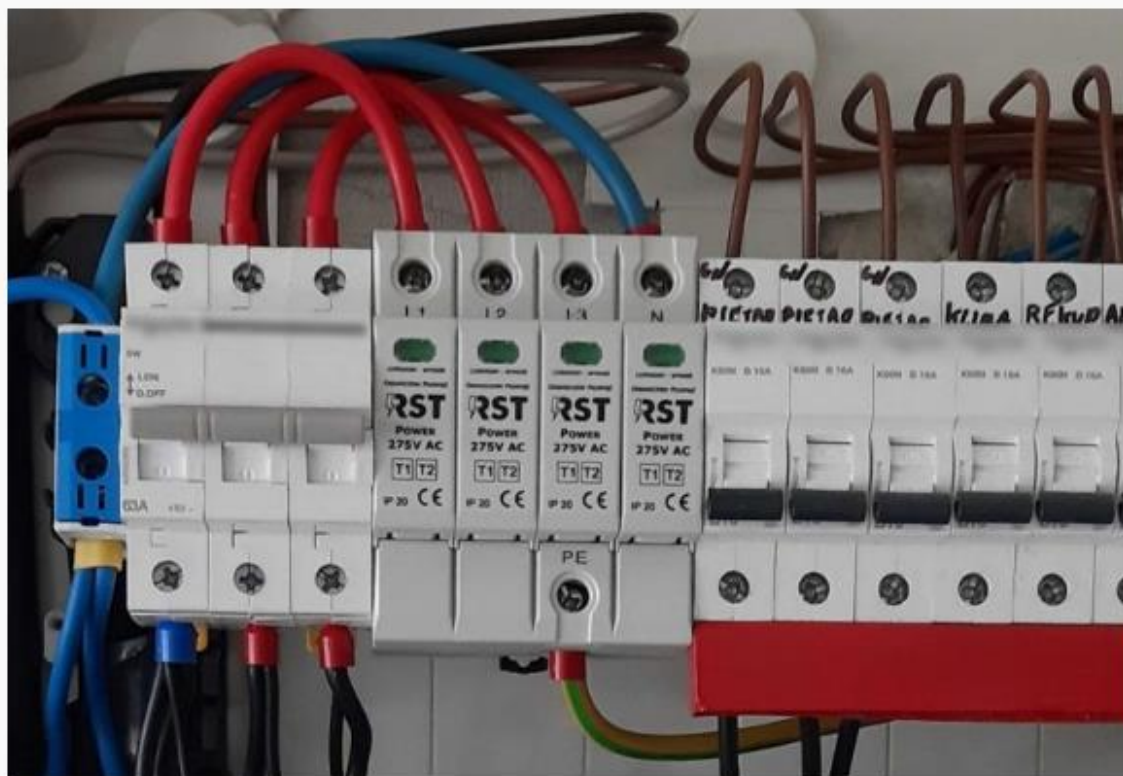
Rys. 1. Ogranicznik przepięć Typu 1+2 połączony z rozdzielnikiem głównym
