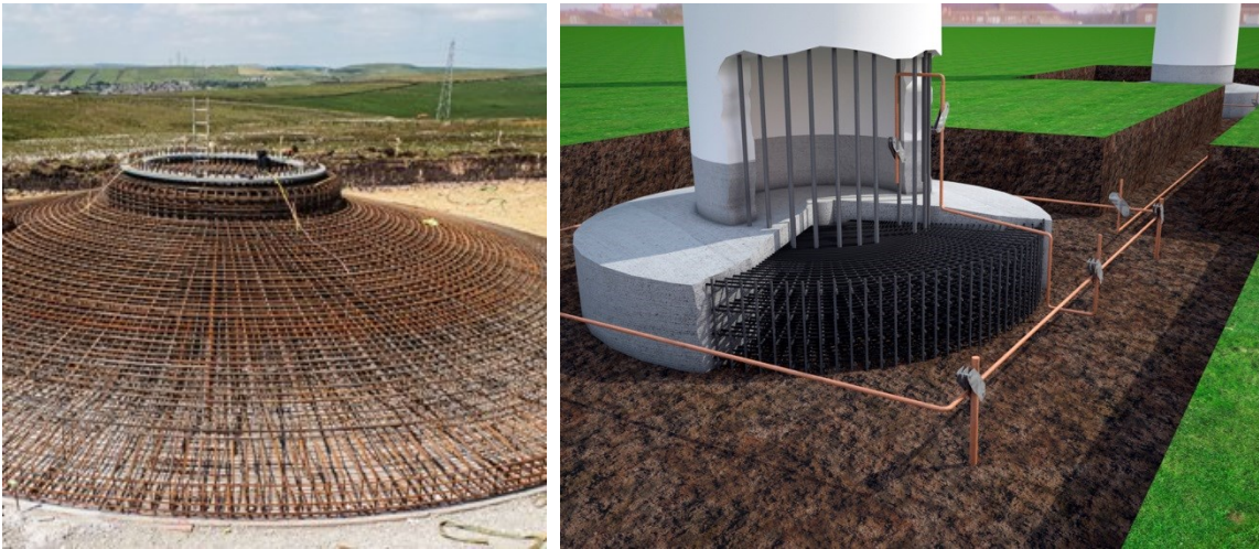
Rys. 11. Zbrojenie fundamentu elektrowni wiatrowej
