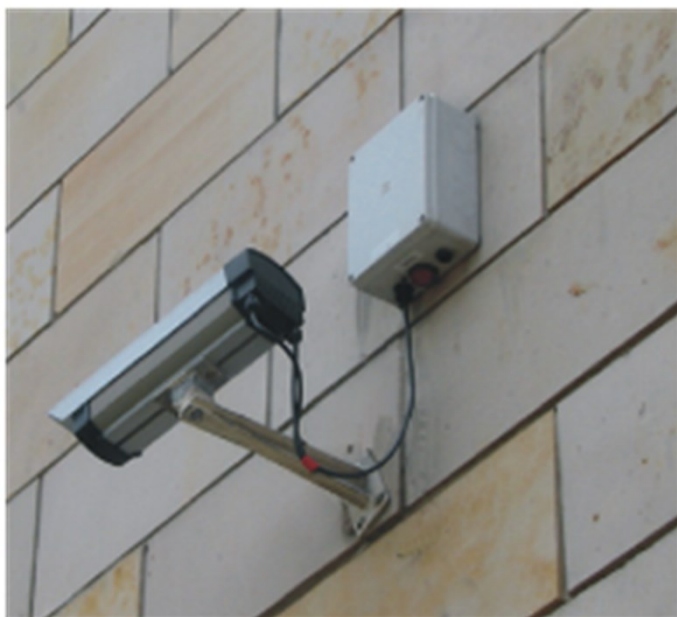
a) Rys. 6. a) Kamera z układem ograniczników przepięć; b) złącze ochrony przed przepięciami typu RST-TV/2xIP/230AC/0/UV
